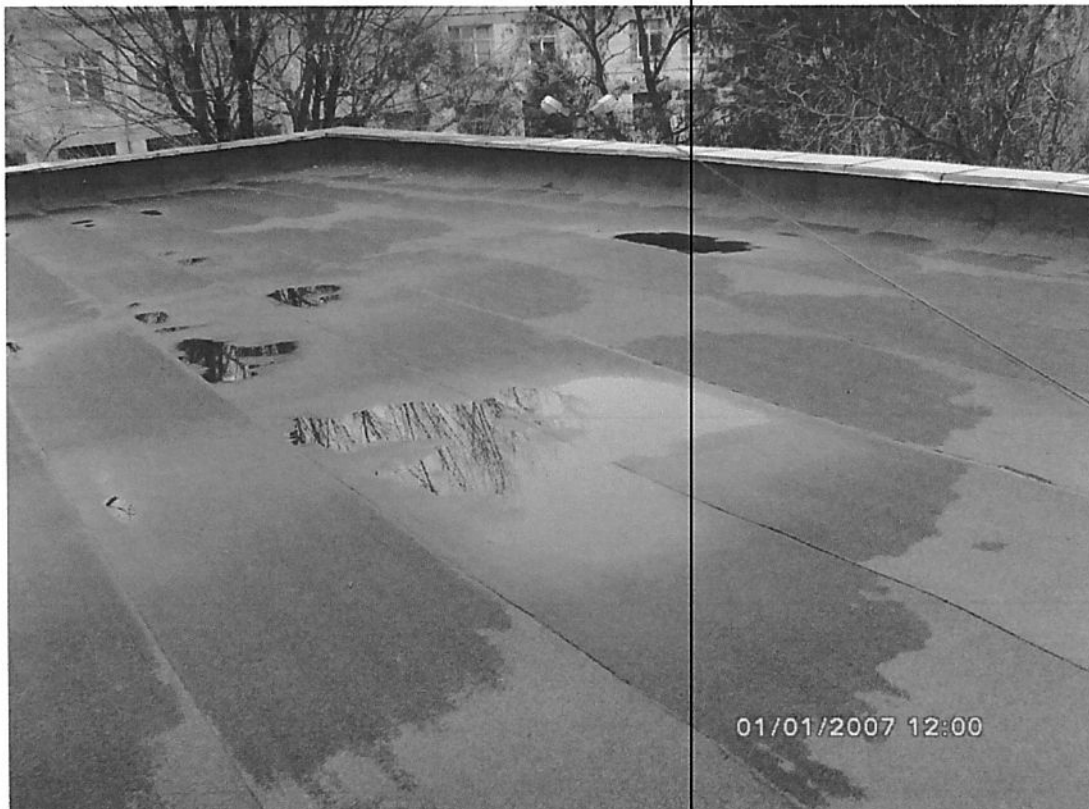
h: Anexa 3: Deformații/inconveniențe învelitoare acoperiș.
