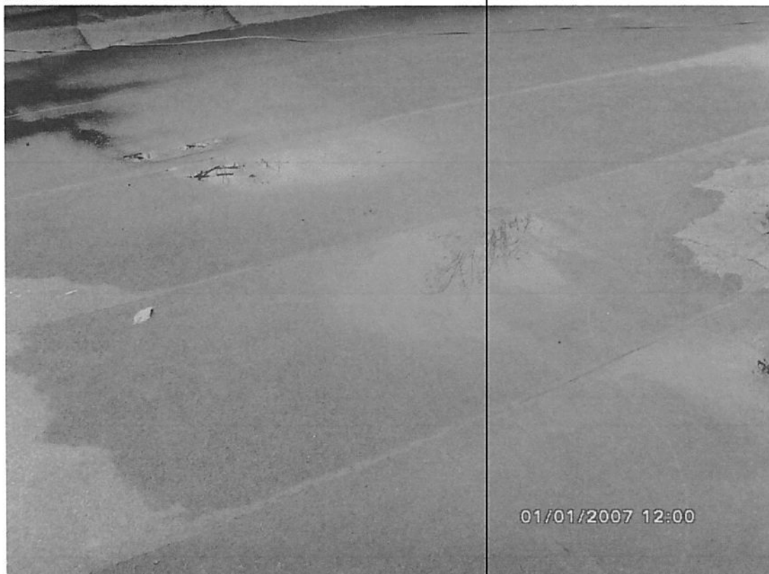
d: Anexa 3: Deformații/inconveniențe învelitoare acoperiș.
