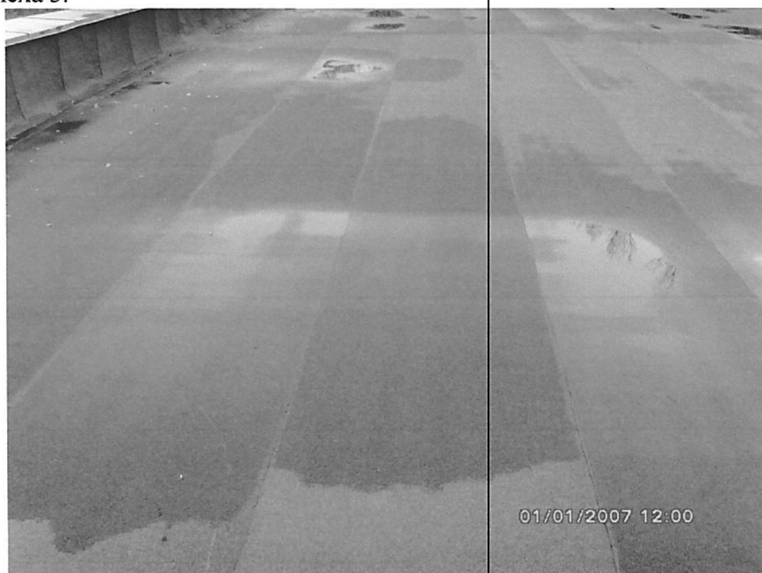
f: Anexa 3: Deformații/inconveniențe învelitoare acoperiș.
