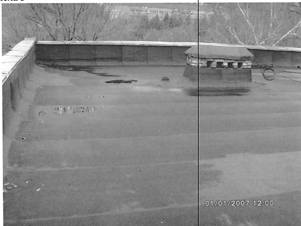
b: Anexa 3: Deformații/inconveniențe învelitoare acoperiș.
